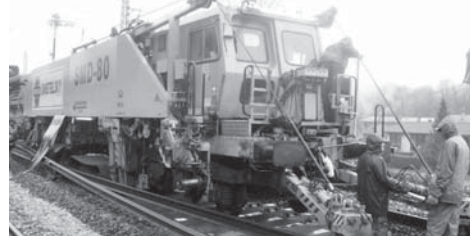
Ремонт пруге укључује и осигурање станица и путних прелаза
