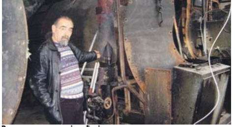
Ремонт котлова траје већ мјесец
