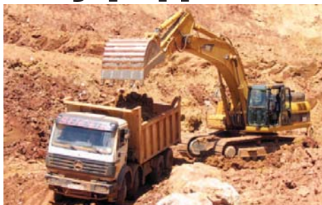
Површински коп Рудника боксита
