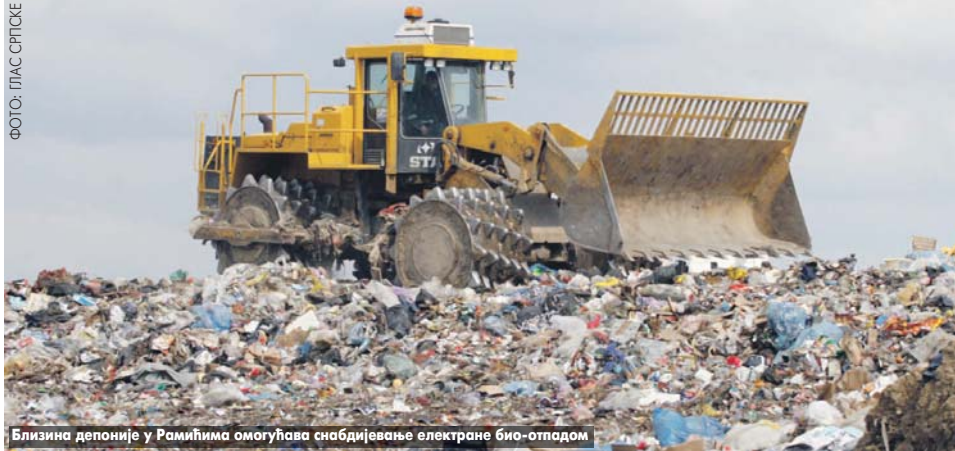
Близна депоније у Рамићима омогућава снабдијевање електране био-отпадом
