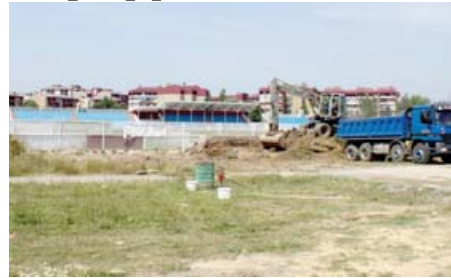
Радови на изградњи источне трибине
