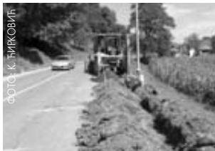
Градња водовода у насељу Гостиљ
