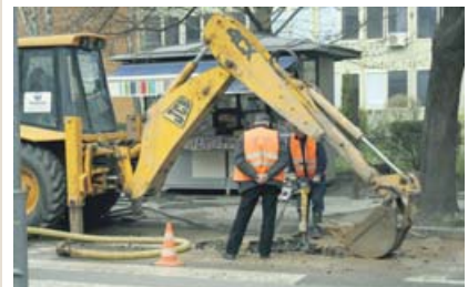
Екипе "Водовода" мијењаће цијеви
