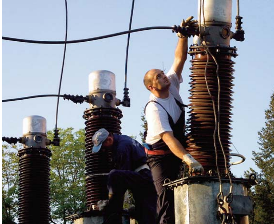
Надлежност над 110-киловолтном мрежом пренесена на "Електропренос БиХ"
