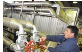
Цијеви на котлу брзо замијењене
