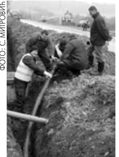
Полагање водоводних цијеви од Борча према Ковању
