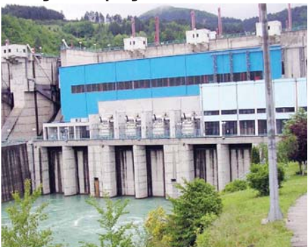
Хидроелектране на Дрини
