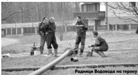
Радници Водовода на терену
