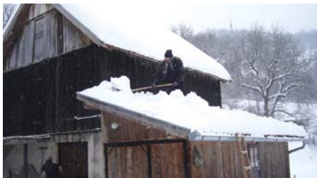
Уклањање снијега са кровова
