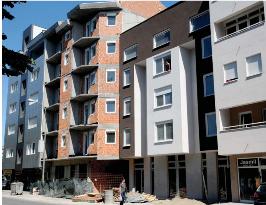
Зграда коју гради "Синергија" још није завршена
