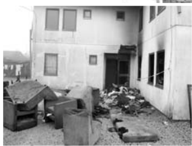
Оштећене ствари из станова испред зграде
