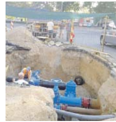
Туњицама. Обнова мреже и замјена цијеви од Фабрике воде у Новоселици до Градског моста и
