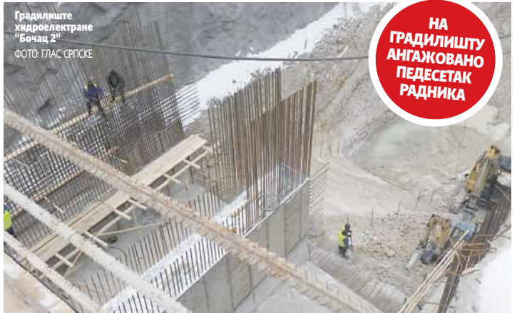
Градiliште хидроелектране "Боцац 2" ФОТО: ГЛАС СРПСКЕ
