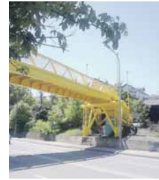
Клије. Замијењене су сливне решетке и санџрано армирано-бетонско постолје испод
