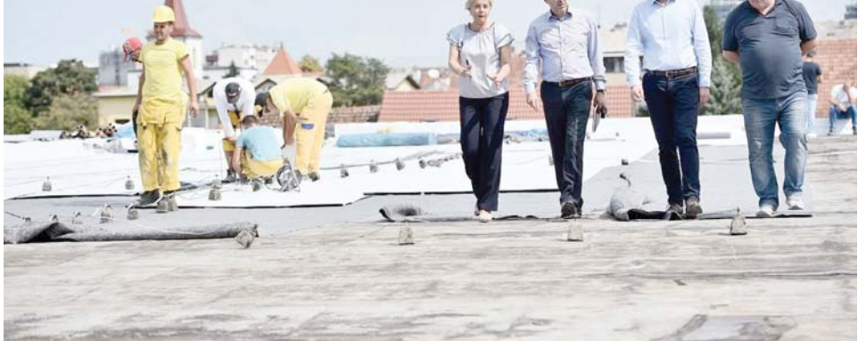
Радојичић се увјерио у квалитет радова на крову Техничке школе ФОТО: ГЛАС СРПСКЕ
