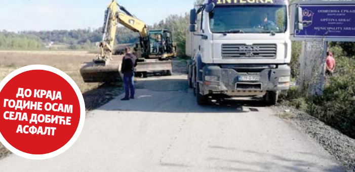
Почела изградња пута Црнаја - Мартинац ФОТО: Д. ЈОВИЧИЋ
